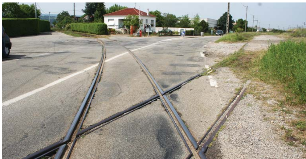
De l'enrobé sera posé autour des voies rue Jules Guesde.
